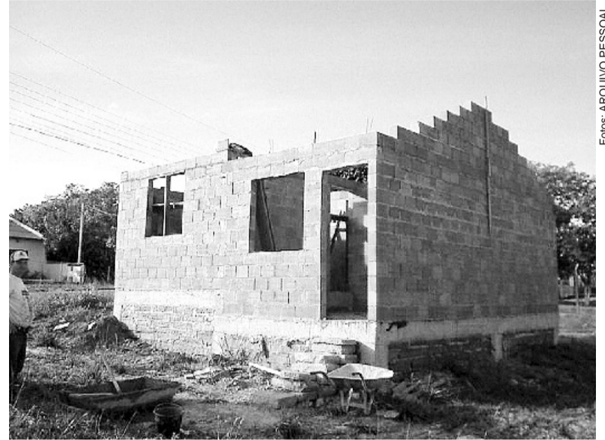
Construção de uma casa em bloco cerâmico com dois dormitórios
